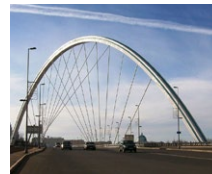
Ramstore Bridge (KZ)
