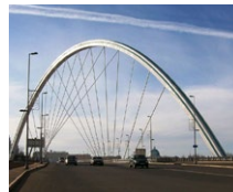
Ramstore Bridge (KZ)
