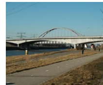
Dintelhaven Bridge (NL)
