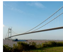
Run Yang Bridge (CN)
