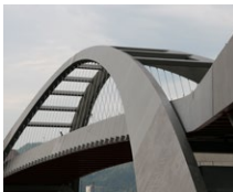
Gleisbogen Bridge (CH)
