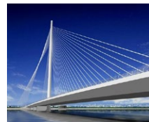
Da Nang Bridge (VN)
