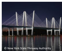
New NY Bridge, NY (US)
